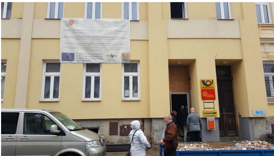
Außenansicht der Baustelle des Handschuhmuseums
