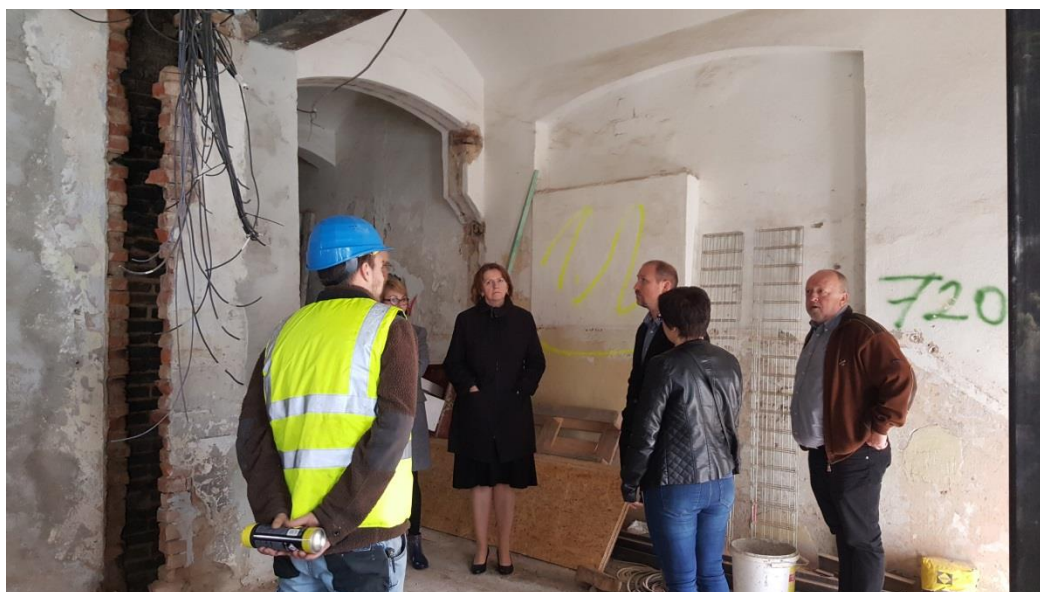
Besichtigung der Baustelle des Handschuhmuseums
