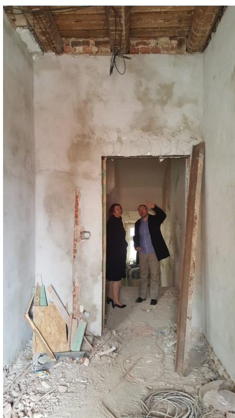
Besichtigung der Baustelle des Handschuhmuseums
