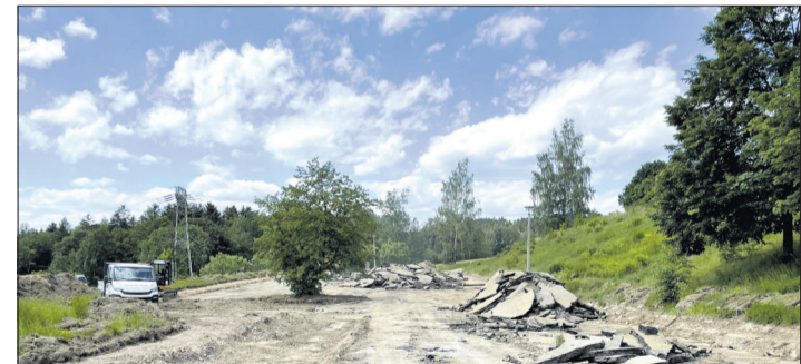
Rückbau Am Wäldchen
