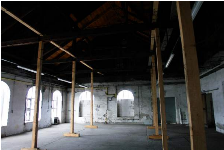
Bild 28: Innenraum 2 Hauptgebäude, Blick zum Südgiebel
