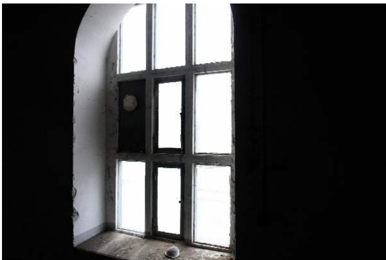
Bild 30: Fenster industrieverglast, vorhandene Rundbögen
