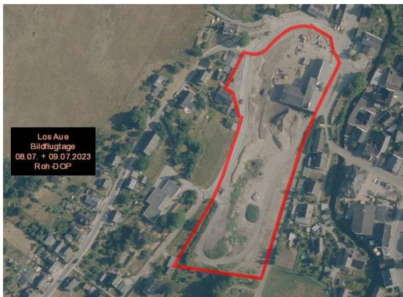
Abb. 4: Roh-Digitales Orthofoto, Bildflug Juli 2023 = aktueller Bestand © Staatsbetrieb Geobasisinformation und Vermessung Sachsen (GeoSN), 2024
