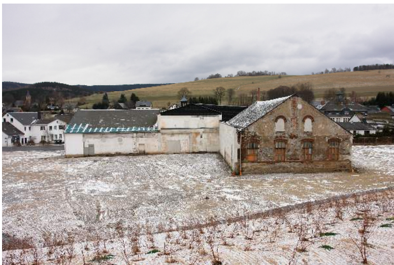
Bild 13: Traufseite Hauptgebäude und Westgiebel Nebengebäude
