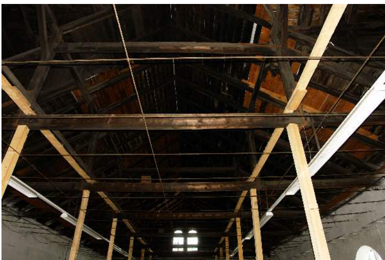
Bild 27: Dachraum Hauptgebäude, provisorische Stützen
