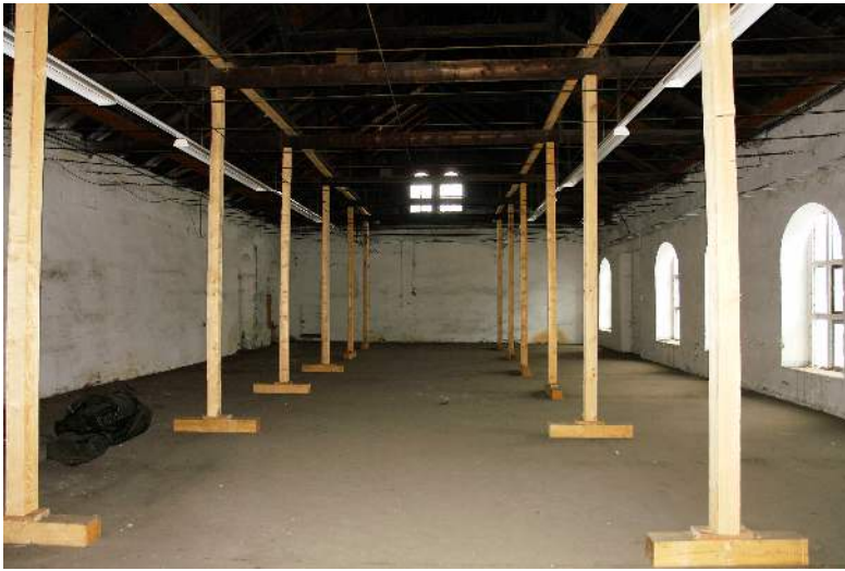
Bild 25: Innenraum 1 Hauptgebäude, Blick zum Nordgiebel, prov. Stützen
