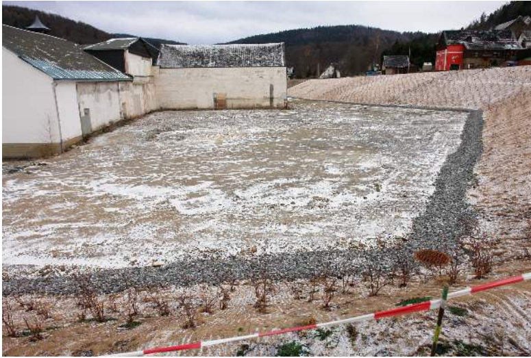
Bild 3: Böschung Gartenweg anschl. Freifläche zum erhaltenen Gebäude
