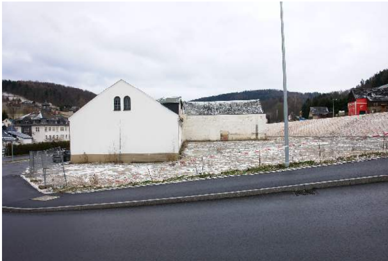
Bild 11: Nordgiebel Hauptgebäude und angebautes Nebengebäude
