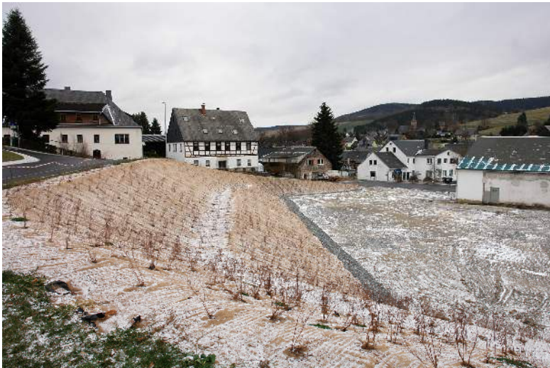
Bild 4: Böschung Gartenweg anschl. Freifläche zum erhaltenen Gebäude
