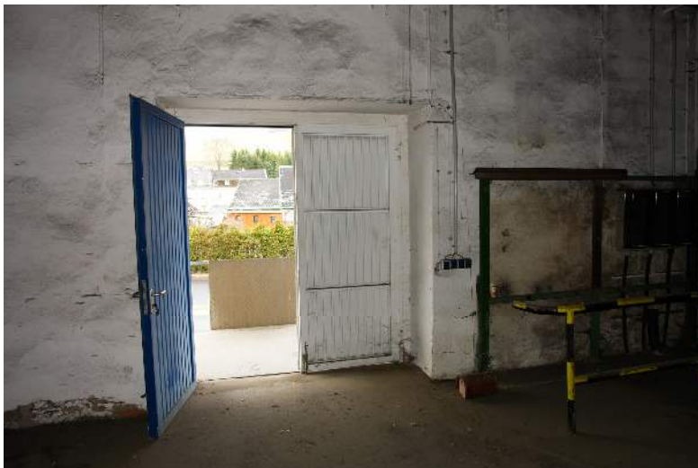
Bild 29: Abschlusstür zur Straße
