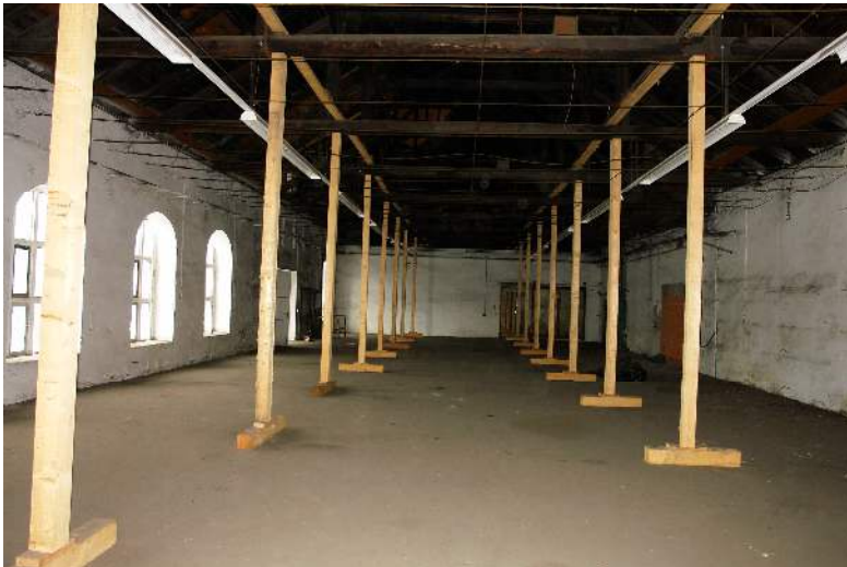
Bild 26: dto., Blick zu Trennwand Raum 2, provisorische Stützen
