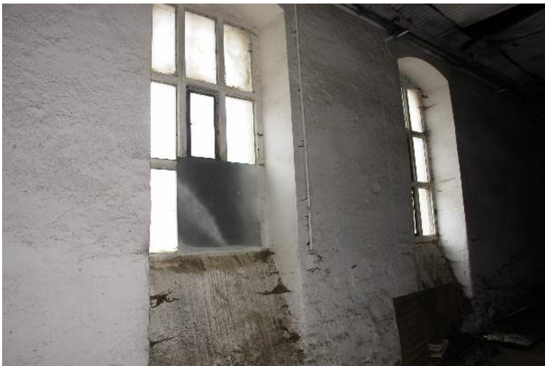
Bild 35: Fenster industrieverglast, Stichbögen original
