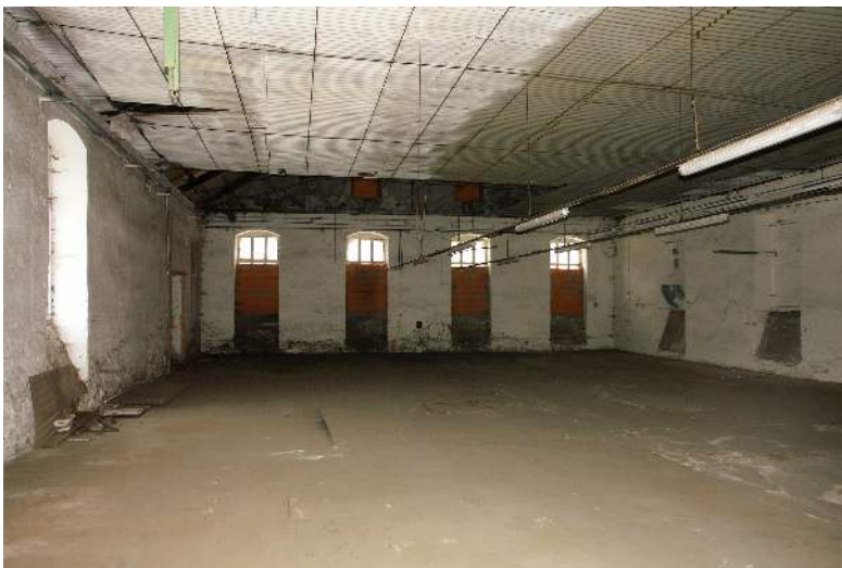
Bild 32: Innenraum Nebengebäude, tlw. einfache Unterdecke
