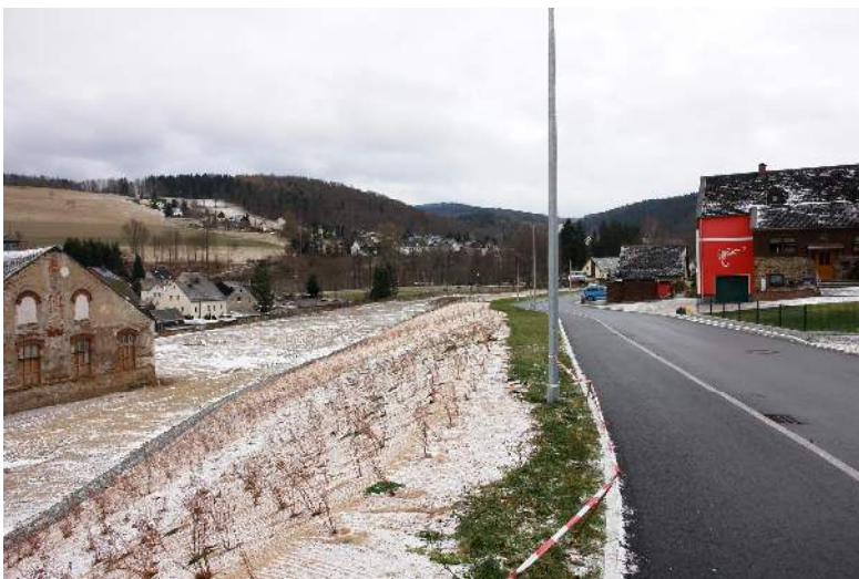
Bild 5: Böschung, anschließend Wohnbaufläche am Gartenweg
